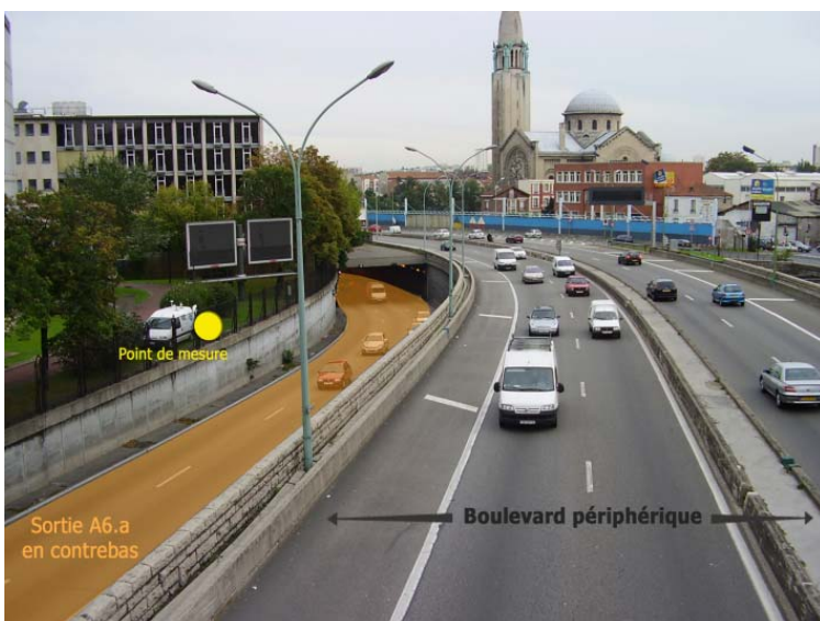
Figure 6 : Axe en tranchée qui canalise la pollution et limite sa dispersion aux alentours
