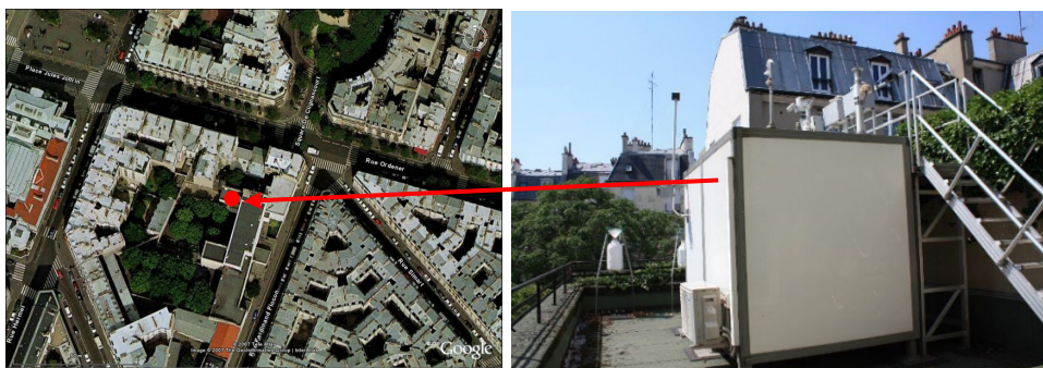
Figure 6 : Site PA18, rue Ferdinand Flocon (Source Google Earth) ; à droite vue vers l'Ouest des points de prélèvements de la station PA18
