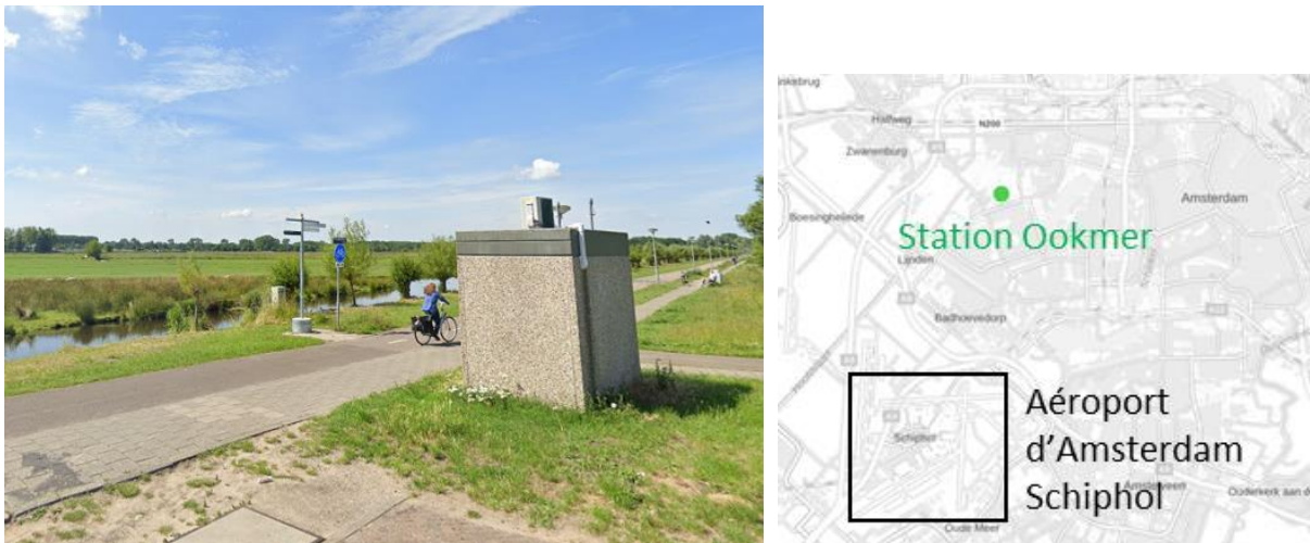
Figure 35 : Photographie et localisation de la station Amsterdam-Ookmer, Pays-Bas
