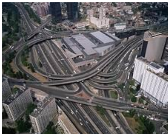
Figure 2 : Echangeur autoroutier de la Porte de Bagnolet (75/93)
